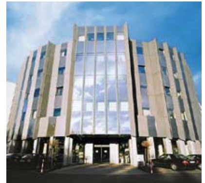
Die A.T.U.-Zentrale in Weiden/Oberpfalz
